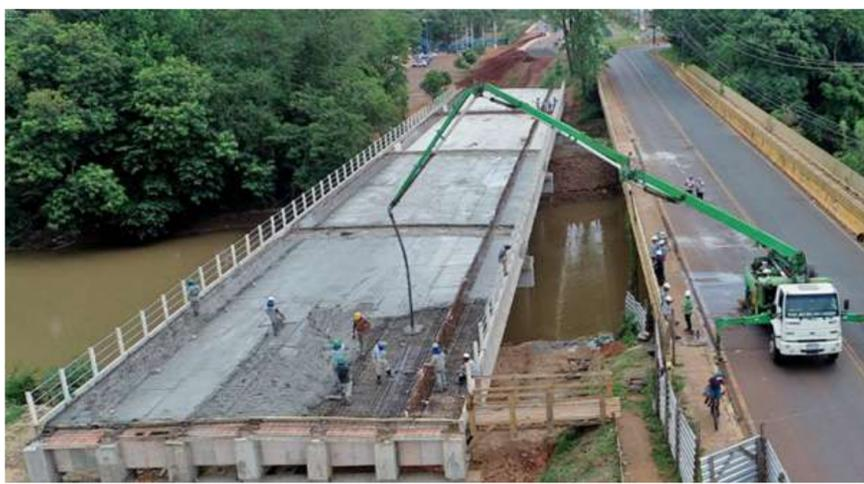
Na última quarta-feira, 9 de novembro, a empresa Trilha Engenharia concluiu os serviços de concretagem da laje estrutural da nova ponte da Avenida Brasil. A laje estrutural é um tabuleiro construído de concreto, sendo ele o responsável pelo suporte de sustentação para facilitar a travessia e tráfego de veículos sobre o novo monumento. O trabalho tem acompanhamento da Secretaria de Obras e Mobilidade (SOM).
