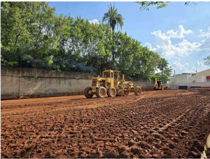
De Itapira As obras do novo
