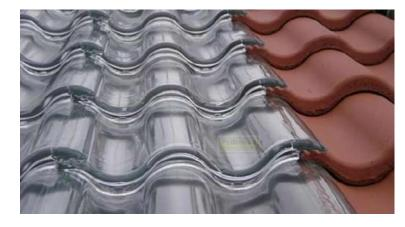
O telhado de vidro é excelente para quem deseja ter uma entrada de luz no ambiente. Esse telhado normalmente é colocado junto com telhado de cerâmica ou de concreto, por isso o vidro é do mesmo modelo que esse tipo de telhado. • Dica 5: Telhado Metálico Galvanizado
