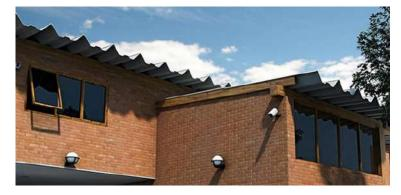
Esse telhado é muito difícil de ser visto. É um modelo que permite que o telhado tenha uma inclinação reduzida. É ideal para cobertura de vãos maiores.
