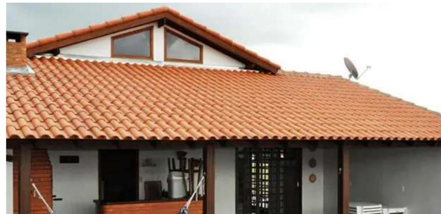
Vamos começar nossa lista com o telhado de cerâmica, um dos modelos de telhados mais utilizados em projetos residenciais.
