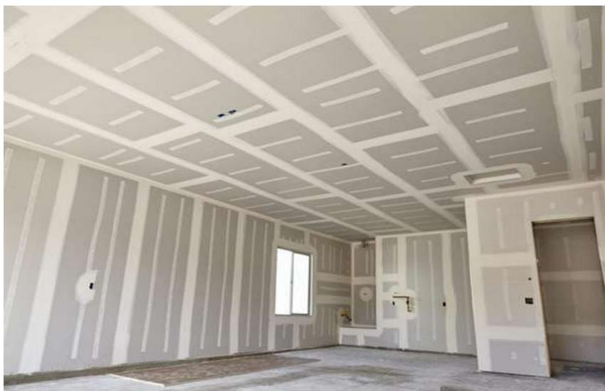
As paredes de drywall oferecem menor desperdício, uma construção mais rápida, leveza e também uma manutenção mais simples. Contudo, por serem formadas de gesso, essas superfícies apresentam uma estrutura menos resistente se comparada à alvenaria tradicional e a falta de cuidado durante manutenções, pode gerar problemas.
