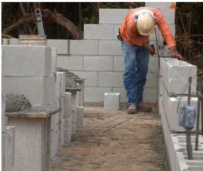
A alvenaria estrutural trata-se de um sistema de construção sem o uso de pilares e vigas para sustentação, onde a própria distribuição dos materiais na estrutura, entrega essa funcionalidade. Porém, para que esse processo aconteça com segurança, é muito importante a escolha dos materiais corretos.
