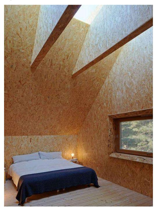
O interessante dessa obra, além do seu aspecto estético extremamente diferente, é que o arquiteto usou técnicas de construção leve, levando forros, paredes de OSB e painéis formados por aparas de madeira. Isso tudo leva a um preço final mais barato.
