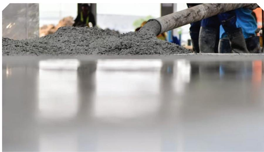
antes da desforma, realizando a cura adequada neste período, facilitando o endurecimento do concreto.
