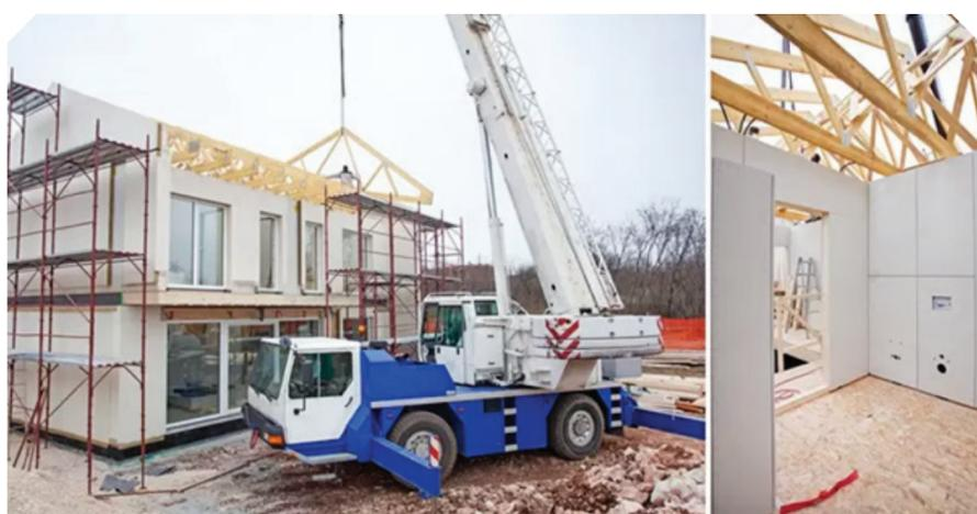
Construção modular ou offsite é o método construtivo que usa módulos individuais pré-fabricados e instalados no local da obra, ou seja, eles são feitos em indústria e apenas montados in loco.
