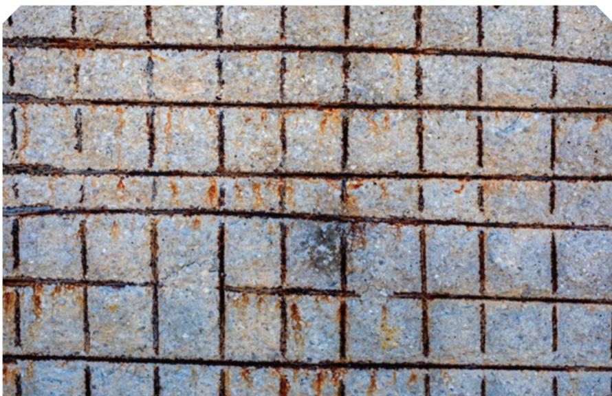
Armadura aparente, manchas de ferrugem pelas peças de concreto armado, fissuras profundas no sentido das barras: tudo isso é sinal de que temos corrosão nas armaduras. Pois é, não tem escapatória! Se acontecer isso, você estará diante de uma manifestação patológica e precisará dar a devida atenção à questão.
